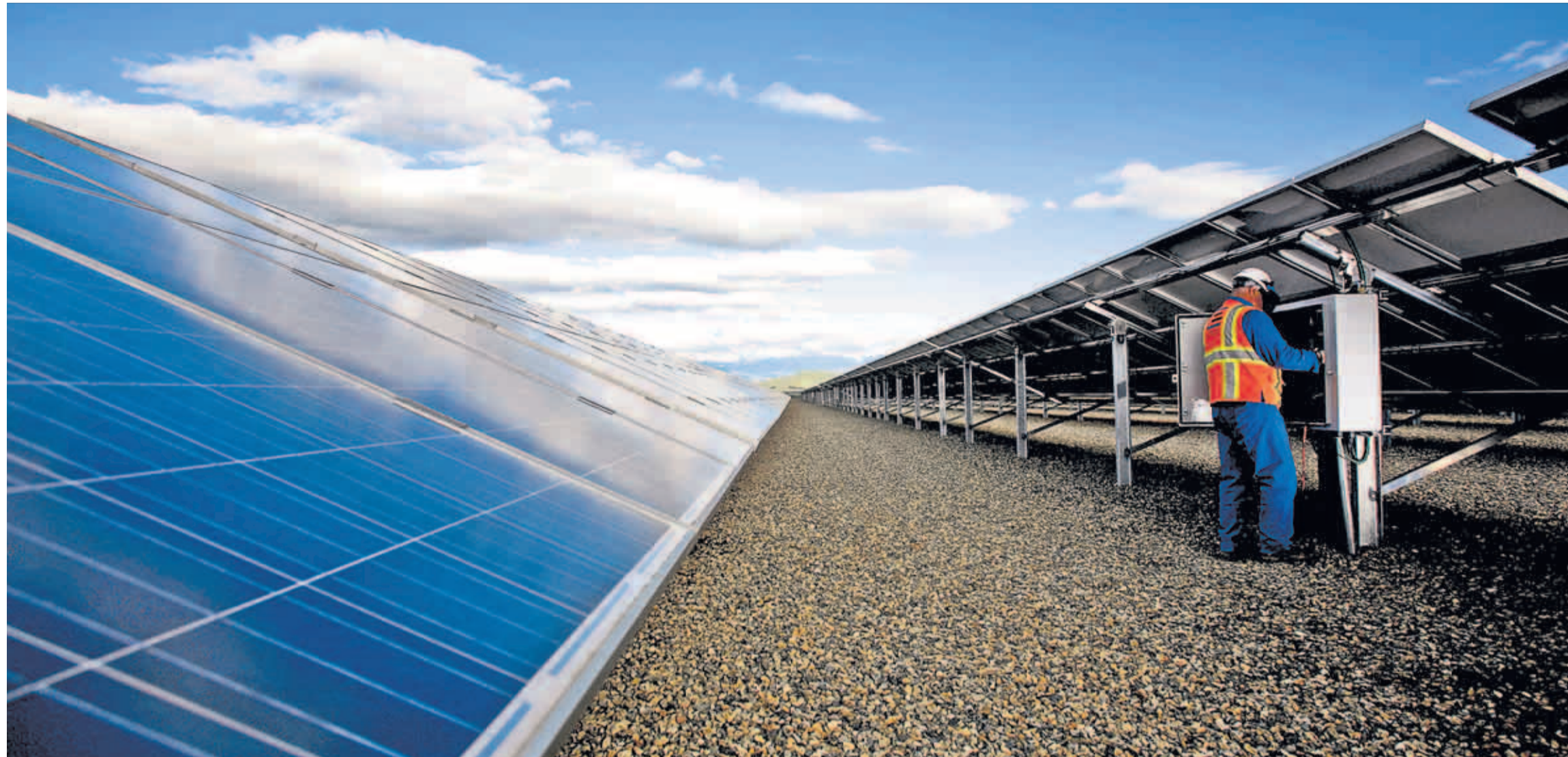
Mechaniker an einem Solarkraftwerk in Kalifornien: Die Sonneneinstrahlung ist im Westen der USA um 25 Prozent intensiver als im Süden Spaniens
